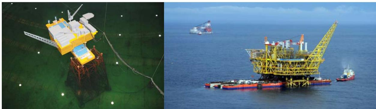
荔湾 3-1 中心导管架平台大型组块整体浮托安装研究与实况
